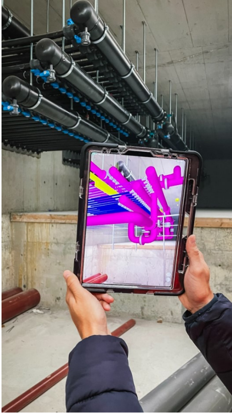
Installationskontrollen BIM2Field, Laborinstallationen, Rückkühler
