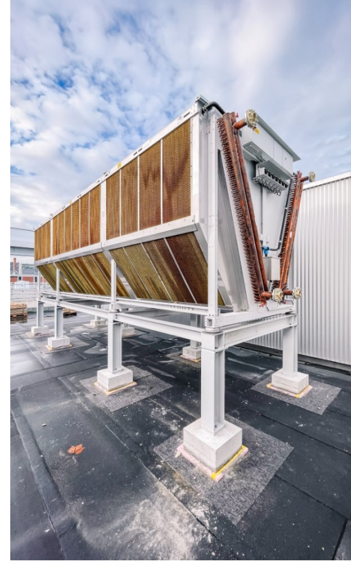
Installationskontrollen BIM2Field, Laborinstallationen, Rückkühler
