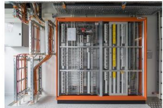
Etagenverteilung Elektro
