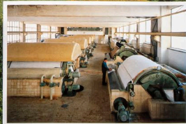
BLEICHEREI In der kontinuierlich arbeitenden Anlage werden die rohen Zellulosefasern in mehreren Stufen von 48% auf rund 94% Weiss gebleicht.
